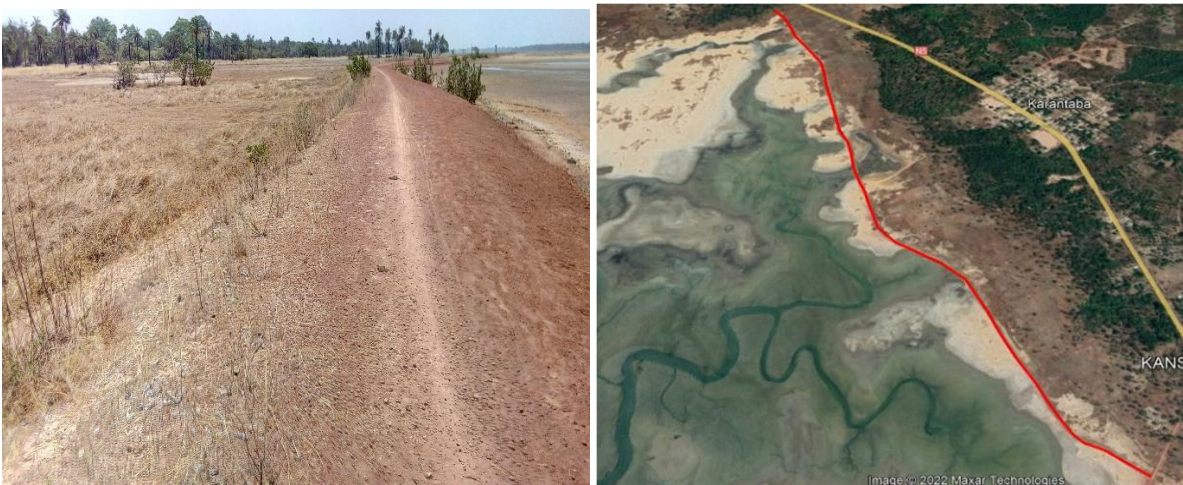
Planche10 : digue d'environ 1, 5 km dont la partie protégée des rizières est sous exploitée à Karantaba (Cliché Sane 2024)
