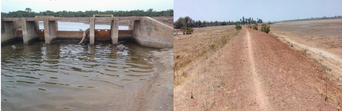
Planche2: quelques méthodes de lutte mécanique dans le bassin versant de Diouloulou : endiguement et micro barrage (Cliché Sané, 2023)
